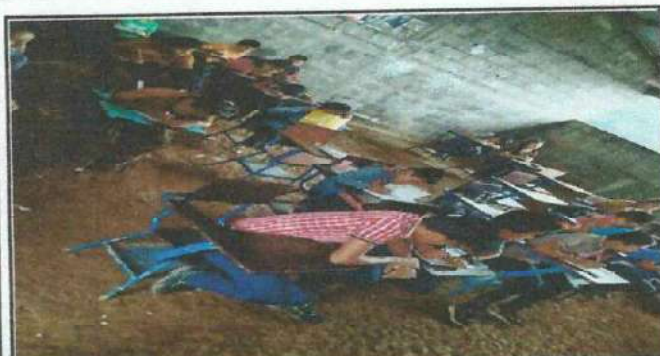
Foto 3: Se observa que el establecimiento necesita piso o torta de cemento.
