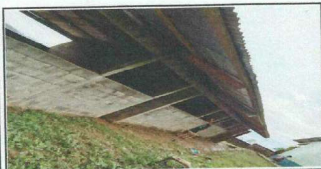
Foto 5: Se observa que la madera del entechado necesita cambio por lo deteriorado.
